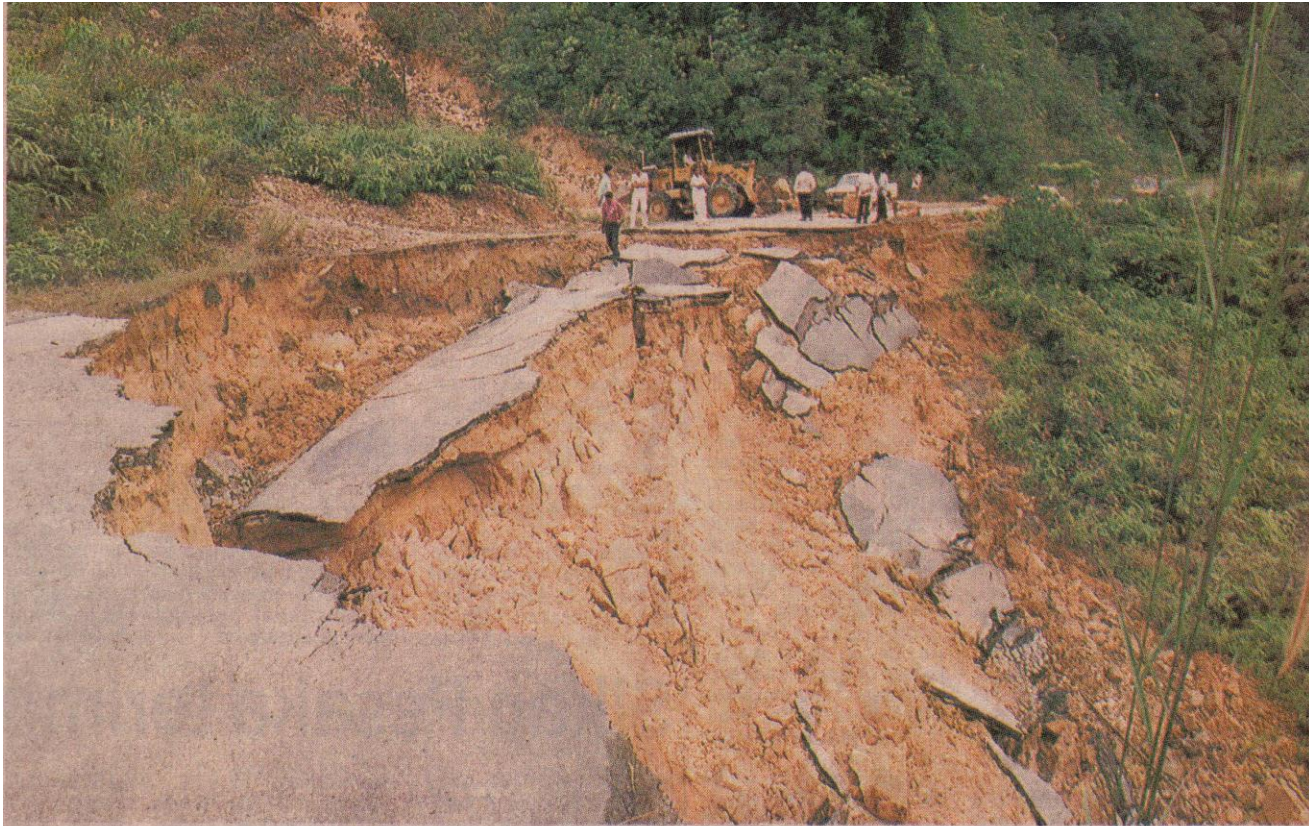
BAHAYA... jalan di Kilometer 32, Jalan Bentong-Kuala Lumpur yang runtuh, semalam. — Gambar oleh Zain Ahmad
